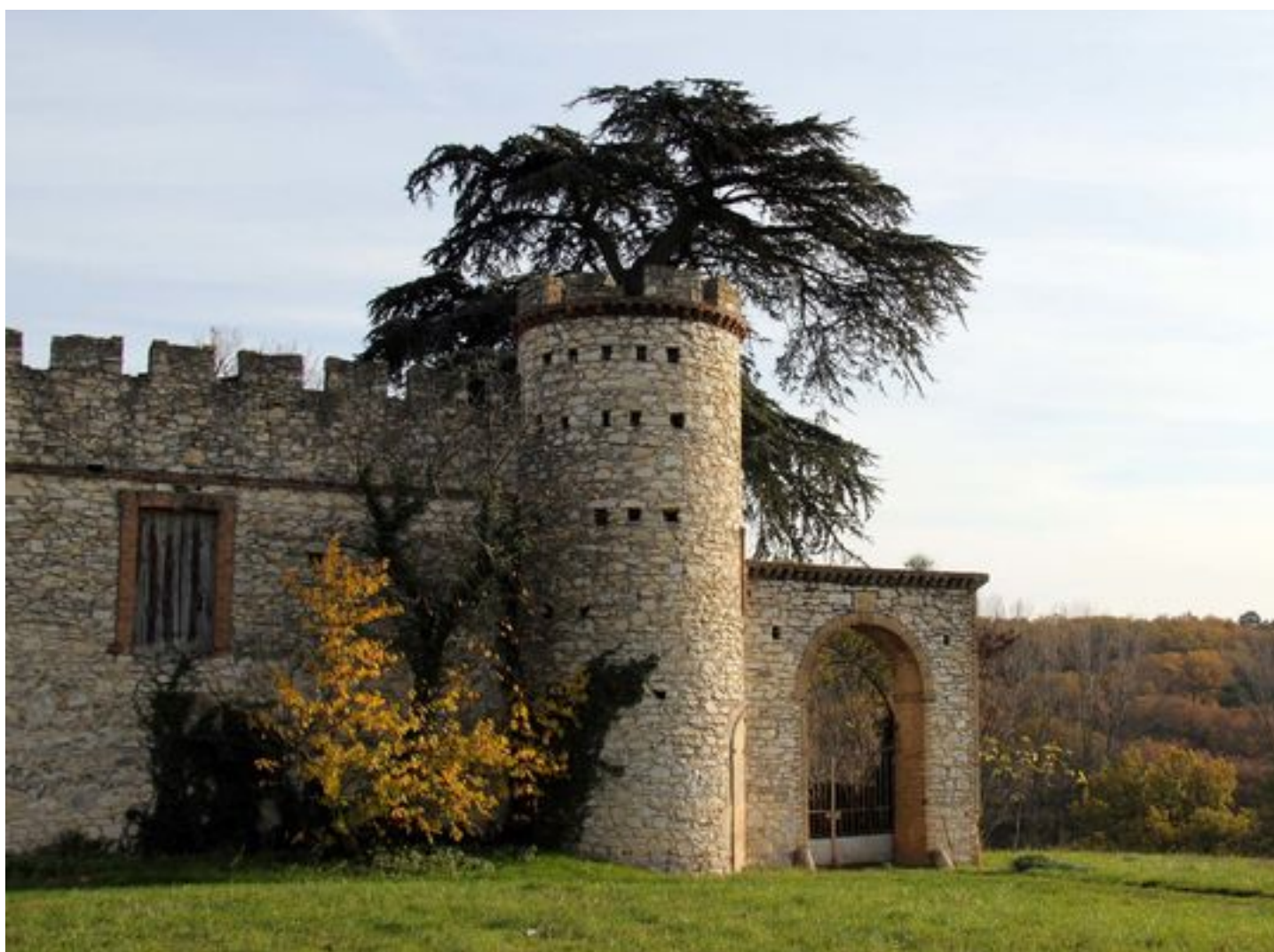
La photo initiale d'une partie du château
